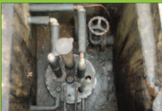
Chiusura e ripristino passo d'uomo.
