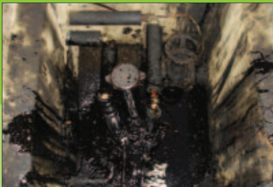
Bonifica del pozzetto e apertura passo d'uomo.
