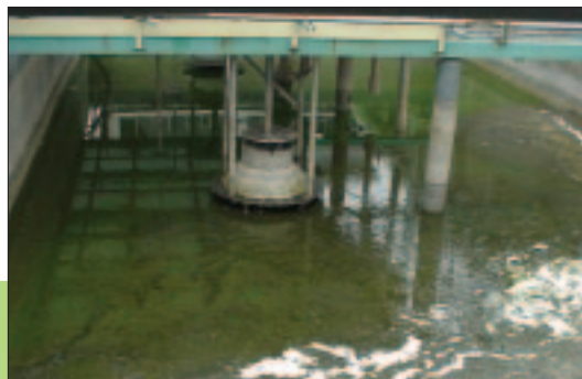
Vasca in calcestruzzo contenente fanghi
